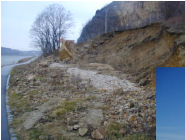
alte Stützwand mit angrenzender Böschung durch Hochwasser der Elbe 2002 vollständig zerstört
