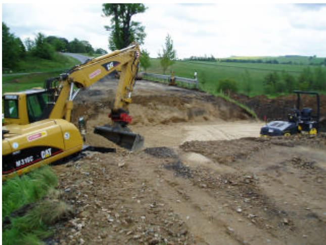
links: Hinterfüllung des Wellstahlrohres
