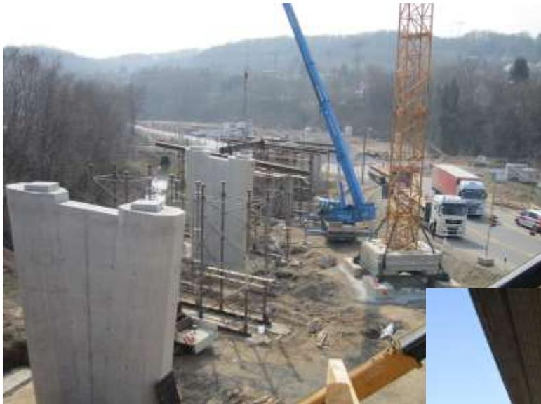
Herstellung der auf Pfählen gegründeten Unterbauten und des Überbaus unter Verkehr der S 84
