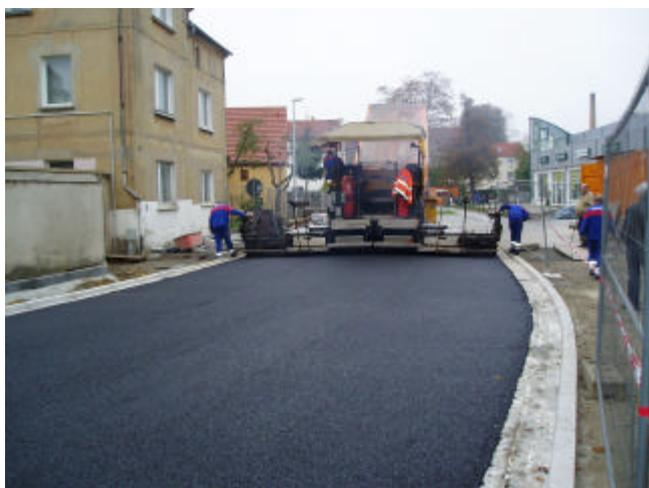
Einbau der Asphaltdeckschicht im Bereich zwischen Brücke BW 9 und Grumbachdurchlass, Blick Richtung Radeberg
