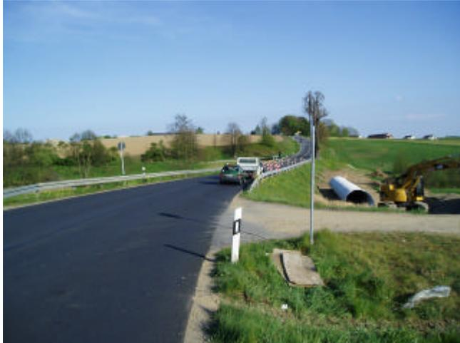
Los 2: Wellstahlrohr seitlich der S 159 vormontiert
