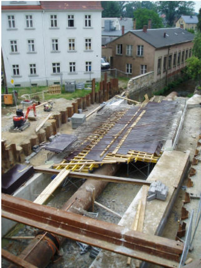
links: Blick auf das Traggerüst mit Schalboden für den
