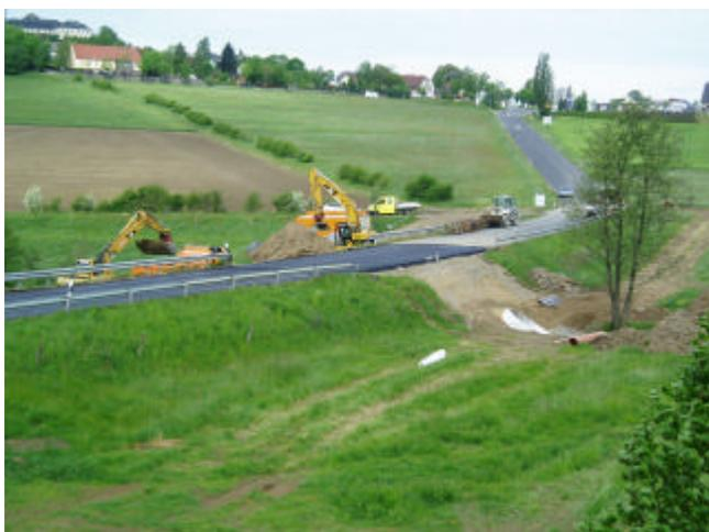
oben: Herstellung der Dammböschung am Ein- und Auslauf
